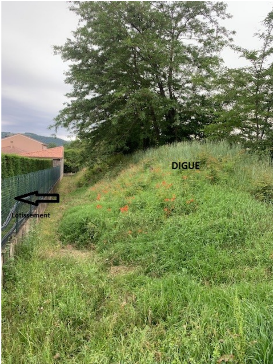
Fig 7 – Digue actuelle avec la végétation et les arbres la recouvrant.
